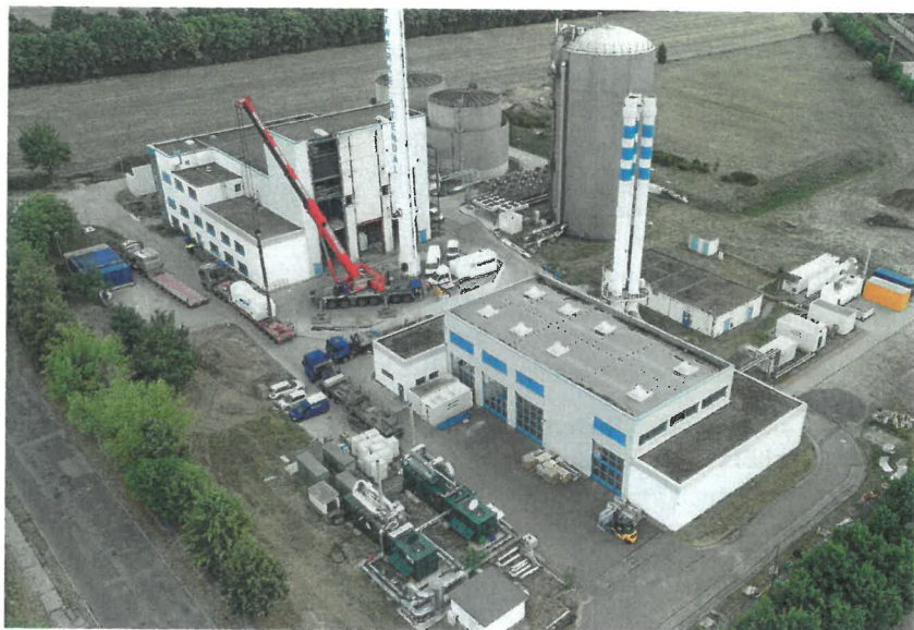
Heizkraftwerk Schillerstraße in Stendal: Neue Motoren machen die Anlage effizienter
